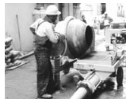
Le ridotte dimensioni facilitano il posizionamento sotto le unità di carico: betoniere, molazze, ecc.
