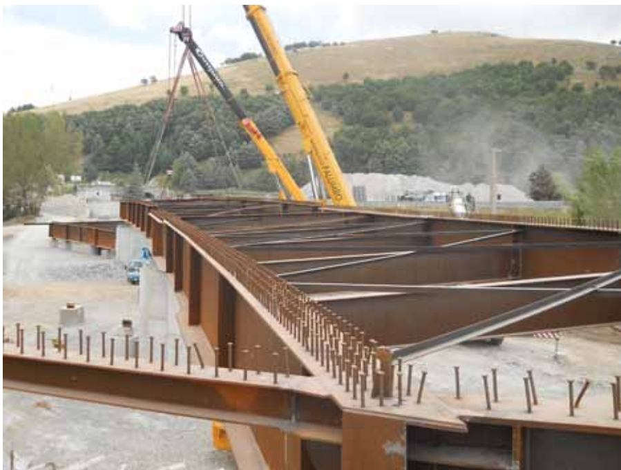
Varo del viadotto Novella, carreggiata Nord
