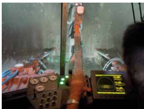
Vista dalla cabina durante la perforazione
