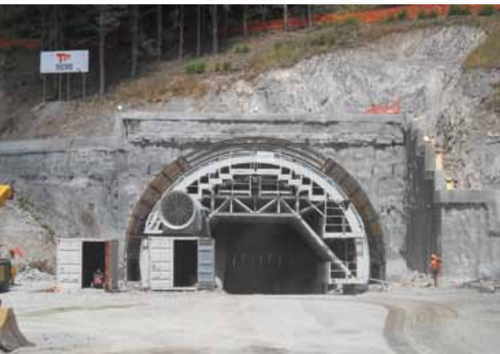
Imbocchi delle gallerie in fase di scavo
