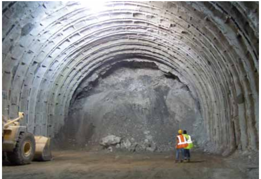
Fronte di scavo della galleria di Campotenese
