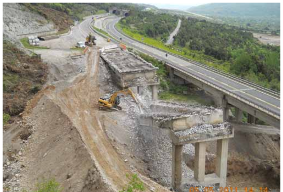
Demolizione meccanica di un viadotto
