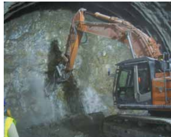
Operazioni di scavo gallerie con escavatore e martellone Montabert, in presenza di argilliti
