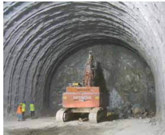
Operazioni di scavo gallerie con escavatore e martellone Montabert, in presenza di argilliti
