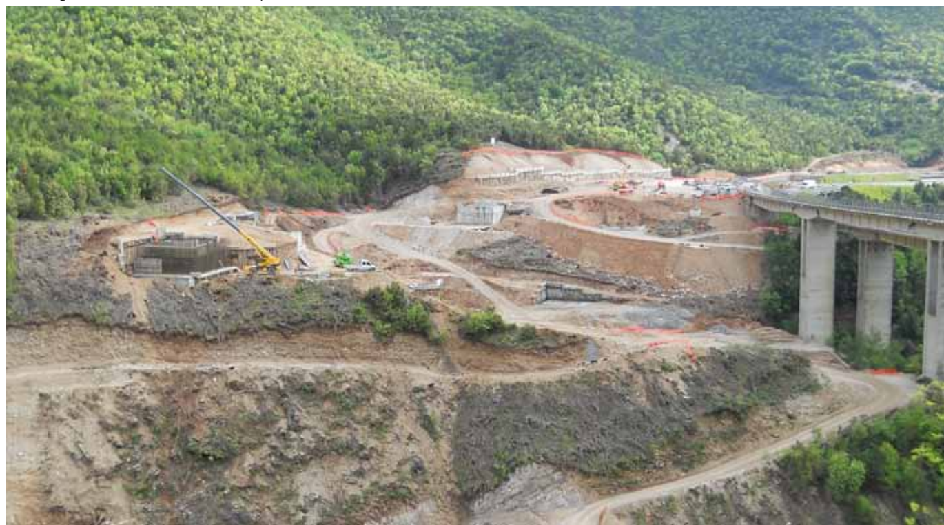
Veduta generale del cantiere e delle piste di servizio
