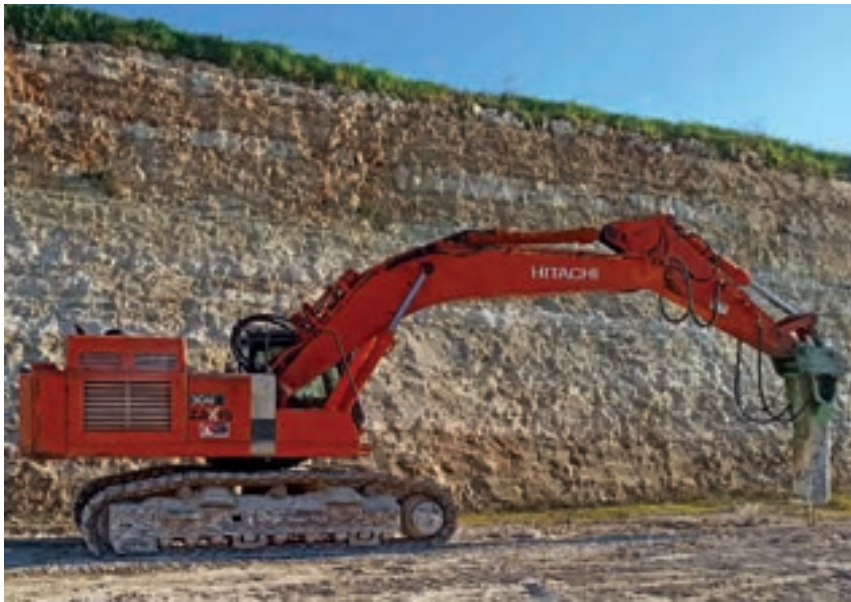
■ Secondo martello Montabert fornito da Air Service presente in cantiere
